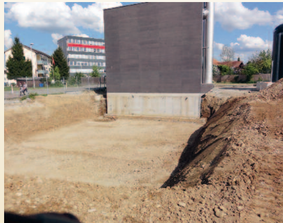
Tranche 2 Excavation pour la réalisation de la centrale de cogénération et l'électrolyseur
